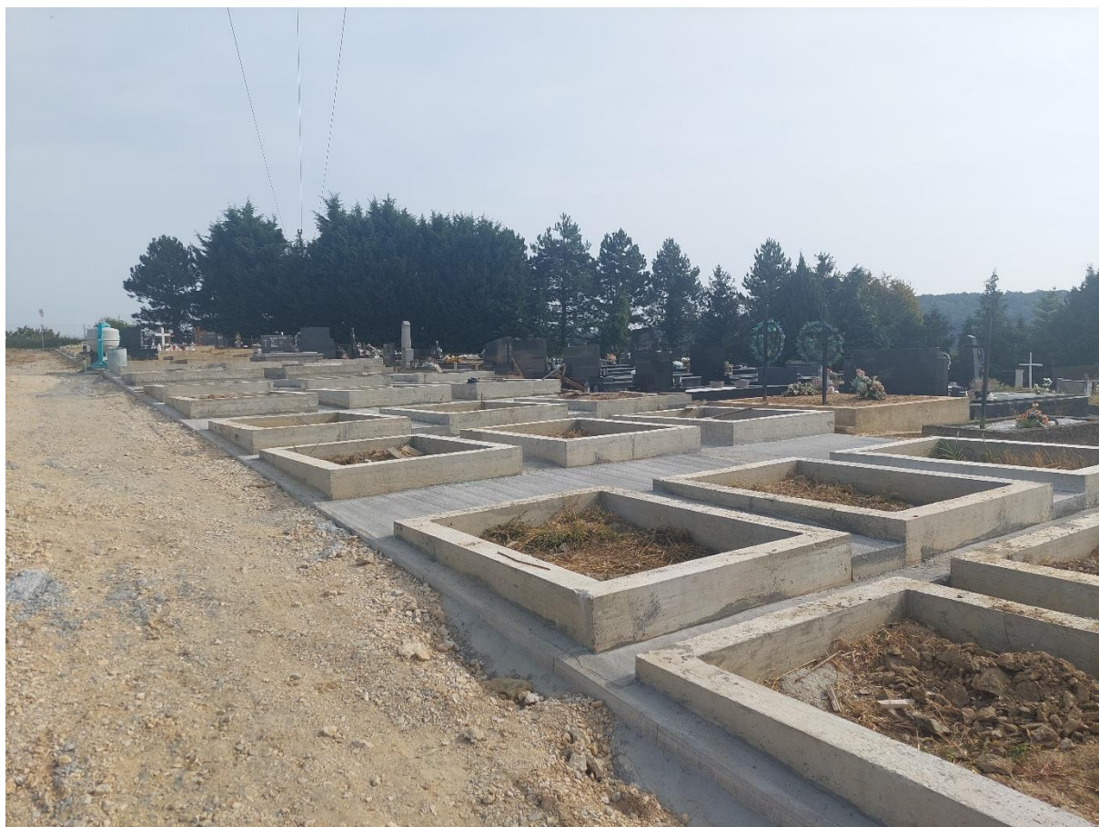
Slika 4 Novoizgrađeni grobni objekti na groblju Donja Zelina
